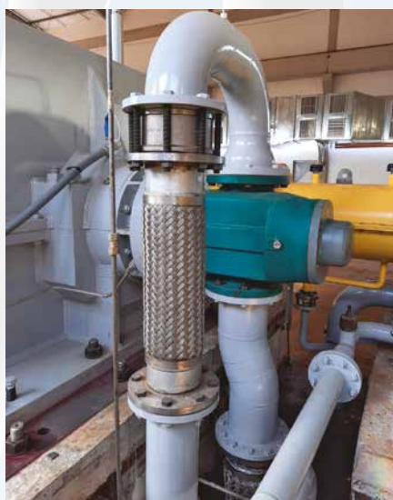
Bomba NOTOS® 2NS946/16H10I instalada em redutor mecânico para lubrificação forçada dos mancais de turbina a vapor
